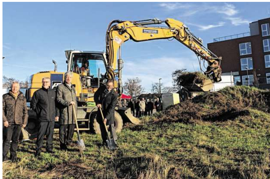
Der Bagger gräbt sich in den Boden des Ringofens: Dort entsteht bis zum nächsten Herbst eine inklusive Kindertagesstätte. Foto: Patrick Nowicki
