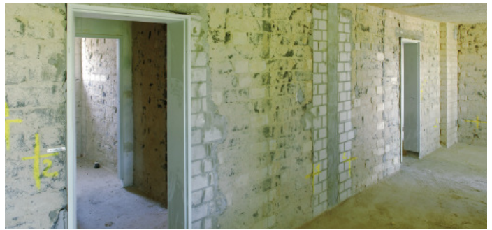
Die Entkernung bis zum tragenden Rohbau schuf Platz für zeitgemäße Raumgrößen und Wohnungsaufteilungen
